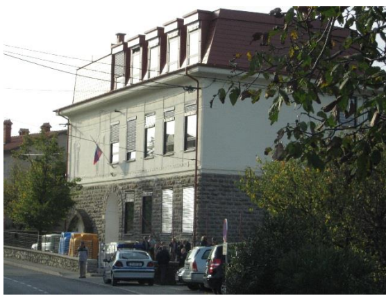
Slika 3: POŠ Kojsko pred energetske sanacije
